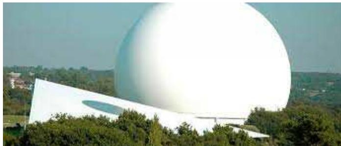
Le radôme a été conçu pour protéger l'antenne cornet PB1. Cette antenne impressionnante : 34 m. de haut pour 54 m. de long, 340 tonnes d'alliage spécial de magnésium et d'aluminium assemblés au millième de millimètre. Cette machine est capable de pivoter sur elle-même à l'horizontal comme à la verticale. Son réflecteur-pavillon de 360 m<sup>2</sup> en forme de cornet lui a valu d'être surnommé la « grande oreille ».
